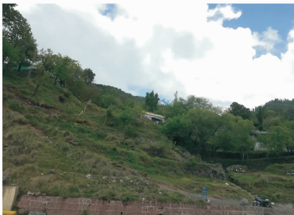
a 水平梯田、排水沟、砌石护坡(陈同德摄于20190424)
