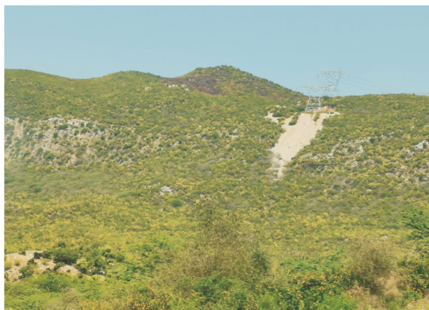
d 高压电线塔基附近边坡侵蚀(焦菊英摄于20190421)
