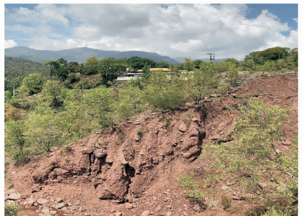
b 居民地旁剧烈侵蚀(陈同德摄于20190418)
