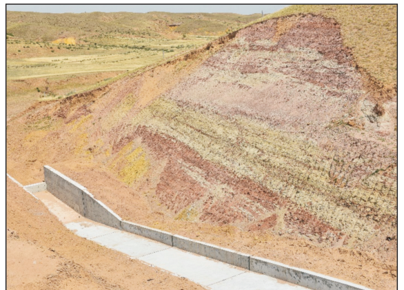
图 18 修建溢洪道边坡开挖(马波摄于 20230624)
