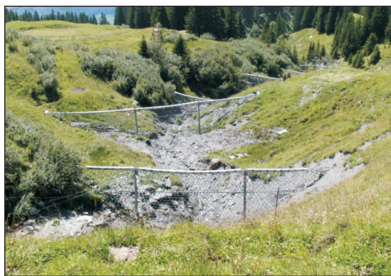
图 11 瑞士伯尔尼州多级泥石流防护柔性网 [21-22]
