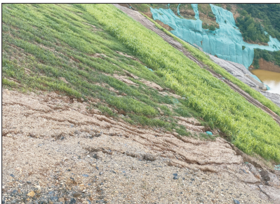
图 6 植被覆盖低及苫盖破损后水土流失状况 (26号弃土场)
