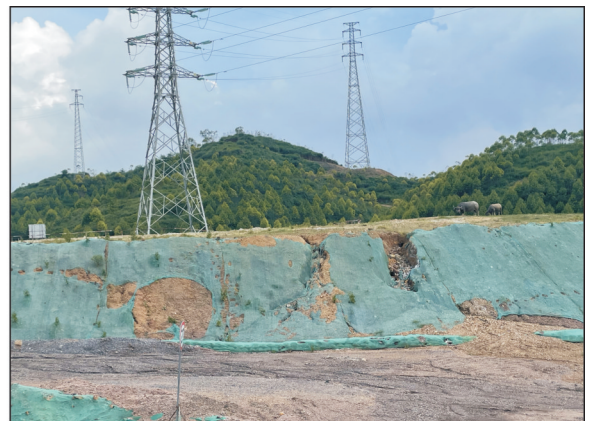
图 6 植被覆盖低及苫盖破损后水土流失状况 (26号弃土场)
