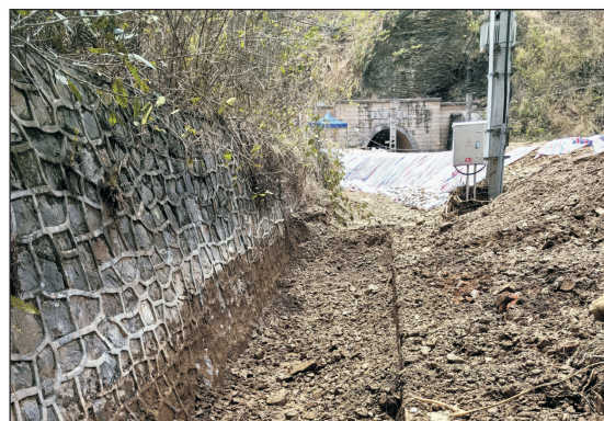
d 沟口排导槽
